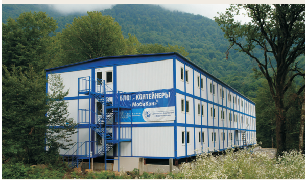
Рисунок 3. Сборно-разборное трёхэтажное здание из блок-контейнеров (г. Сочи)
